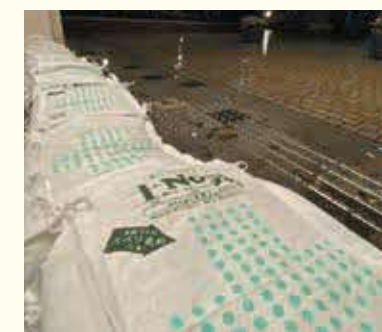
土のうを設置したエントランス
